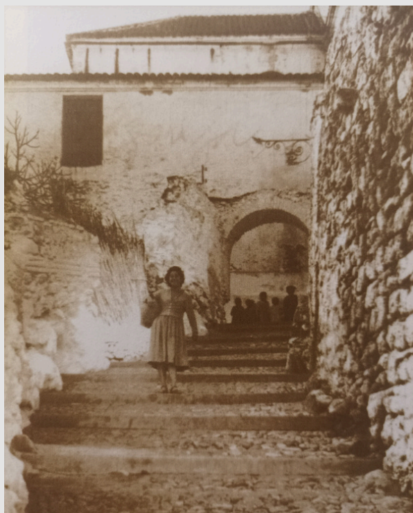
Vista del Arco del cobertizo hacia 1960.
