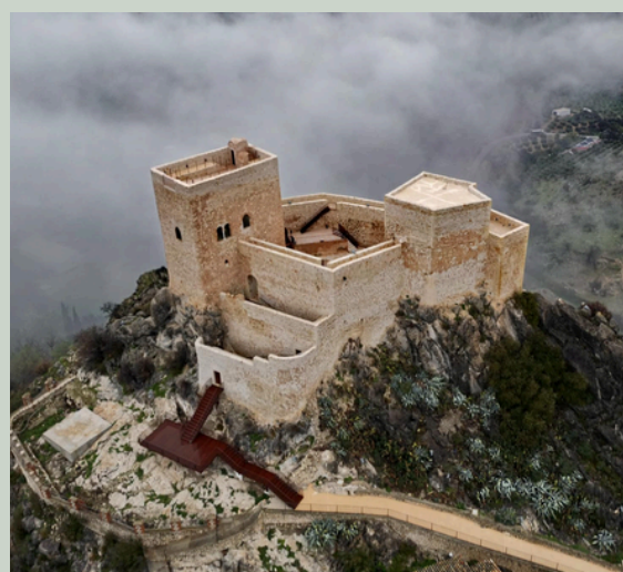
Vista aérea del castillo de Luque tras su restauración
