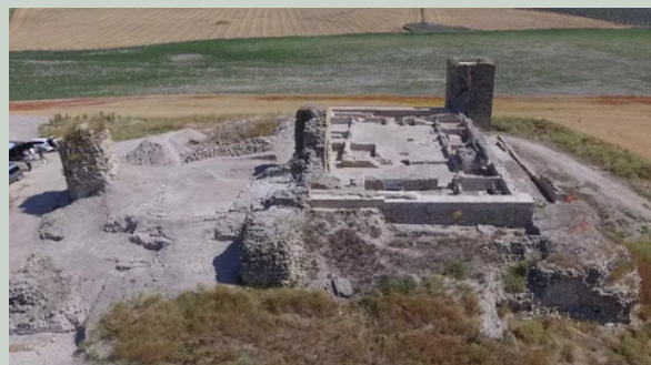
Vista dron del castillo de Dos Hermanas tras la intervención de 2024 (Paco Barranco. Publicada en Cordopolis).
