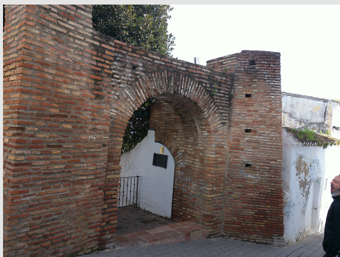
Vista actual del Arco del Cobertizo.
