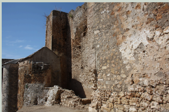
Vista general de la muralla de Hornachuelos
