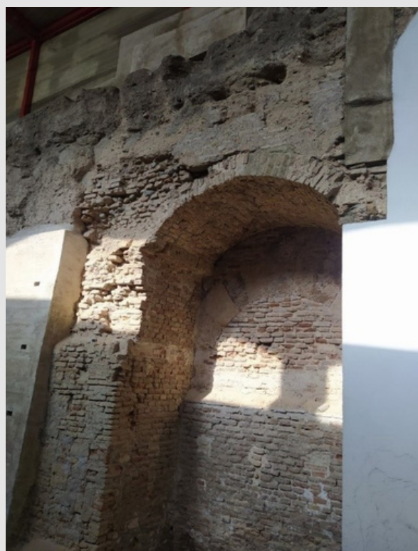
Figura 5. Detalle de la puerta situada en el lado noroccidental del castillo, abierta probablemente en época bajomedieval cristiana. (Foto: Damiana Pitzalis).
