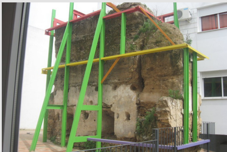
Figura 1. Muro de tapial de la Calle Escuelas.
