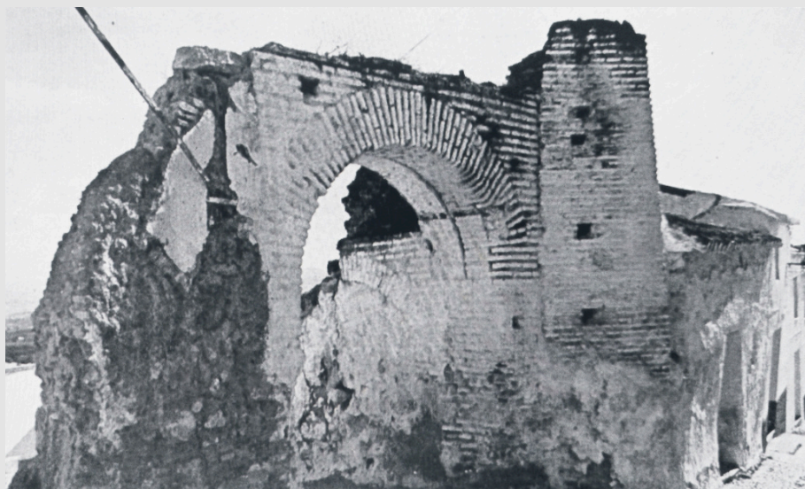
Vista del Arco del Cobertizo hacia 1980.
