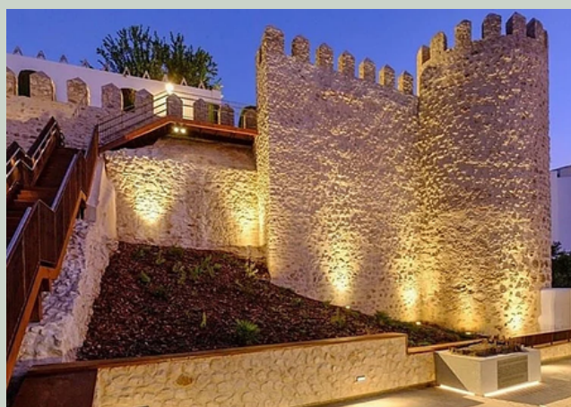
Aspecto actual de la ladera sur de la muralla de Cabra. (Felipe Osuna. En ABC Córdoba digital)
