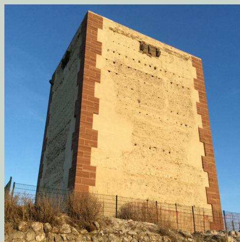
Vista de la torre de Castillo Anzur
