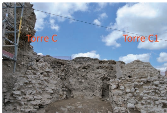
(Fig. 14) Acceso directo entre dos torres con base de mampostería y alzado de tapia al castillo de Moclín previo a la etapa nazarí.
