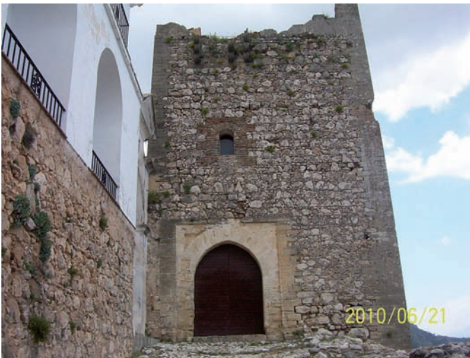
(Fig. 16) Fachada oeste de la torre puerta de acceso al castillo de Moclin. En la clave del arco de acceso se encuentra tallada el escudo de la banda de los reyes nazaríes.
